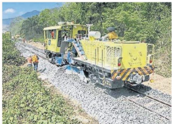
■维修铁路的重型机械在进行工作。
